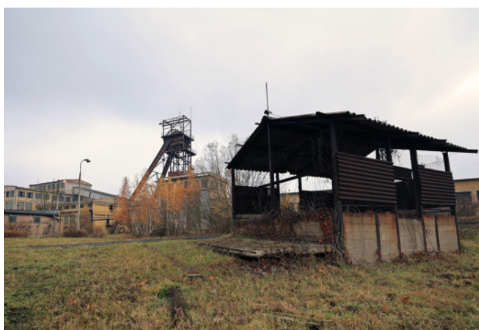
Areál dolu Centrum, který projde významnou revitalizací. Prosinec 2025.
